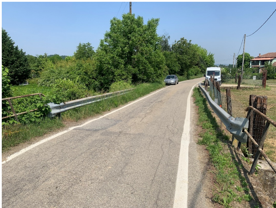
Stato di fatto (barriera stradale doppia onda, sviluppo 20+20 m)
