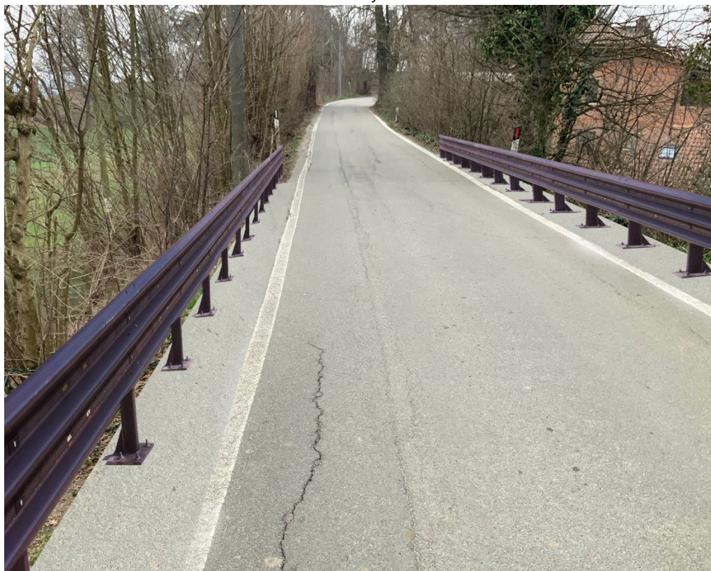
Stato di progetto (cordolo con barriera stradale tripla onda, sviluppo 20+40 m)
