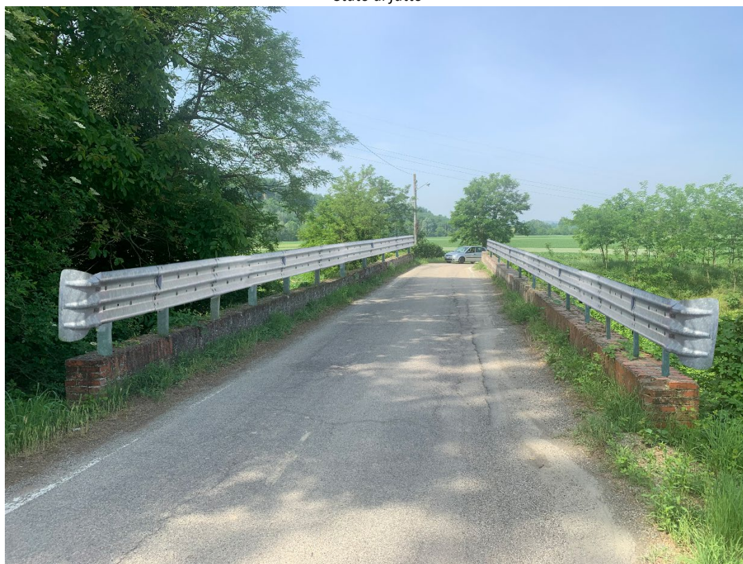
Stato di progetto (barriera stradale tripla onda, sviluppo ripristino 36+36 m)
