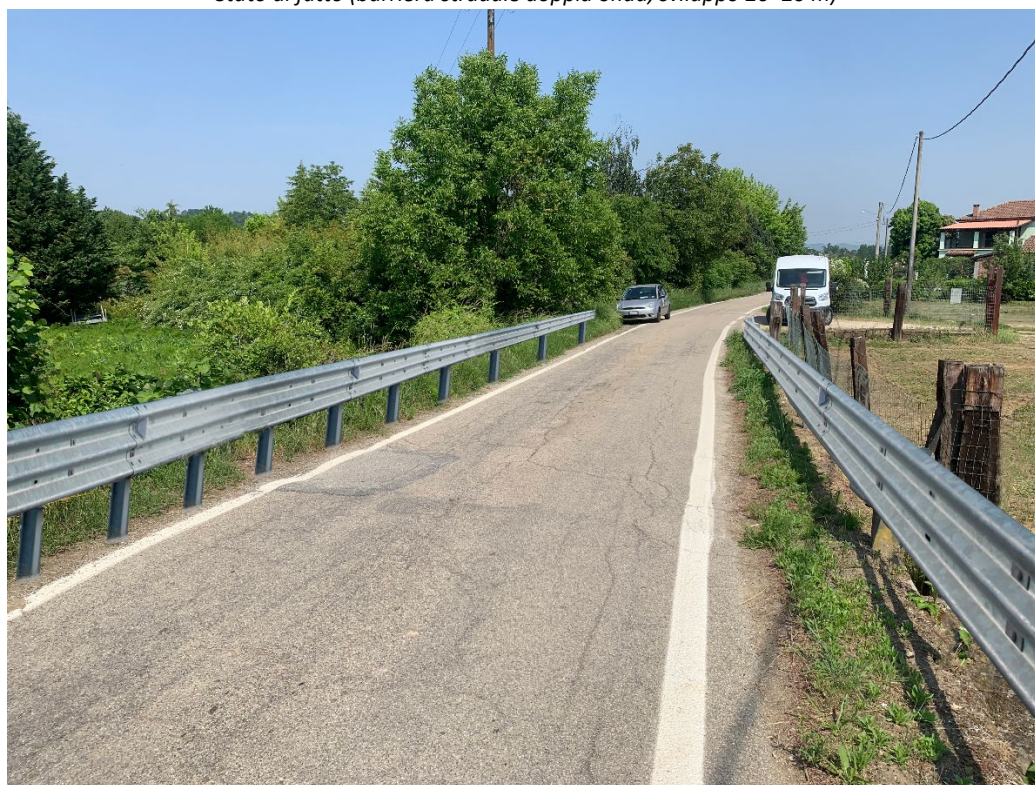
Stato di progetto (barriera stradale tripla onda, sviluppo ripristino 20+20 m e prolungamento 5+5 m)
